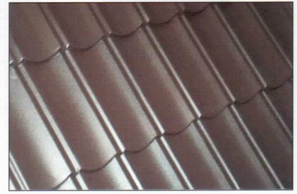
Povrch bez kamenného granulátu
